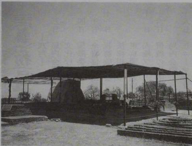
マヤ堂修復現場近影（4月下旬撮影）
