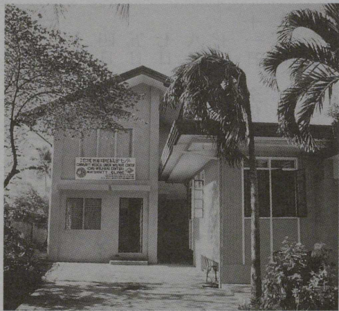
同会が建設した地域医療センター
