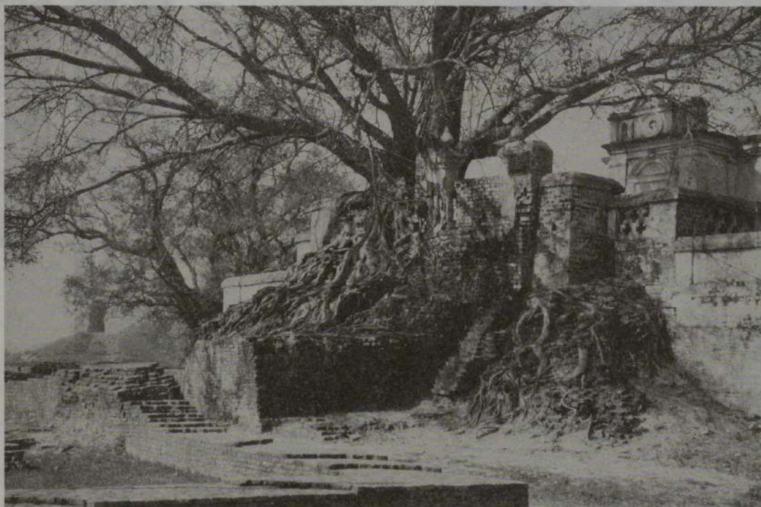
菩提樹の侵蝕で崩壊寸前のマヤ堂
