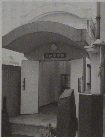
「永代供養廟」の正面
