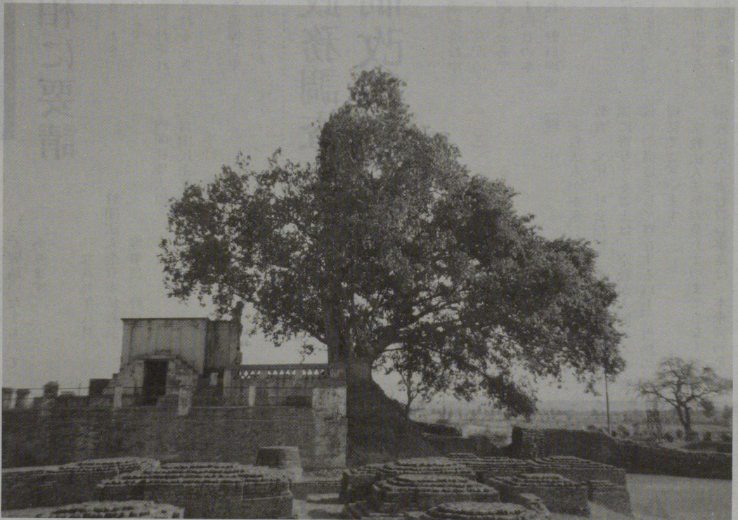
菩提樹の根が侵蝕し、崩壊の一途をたどるマヤ堂
