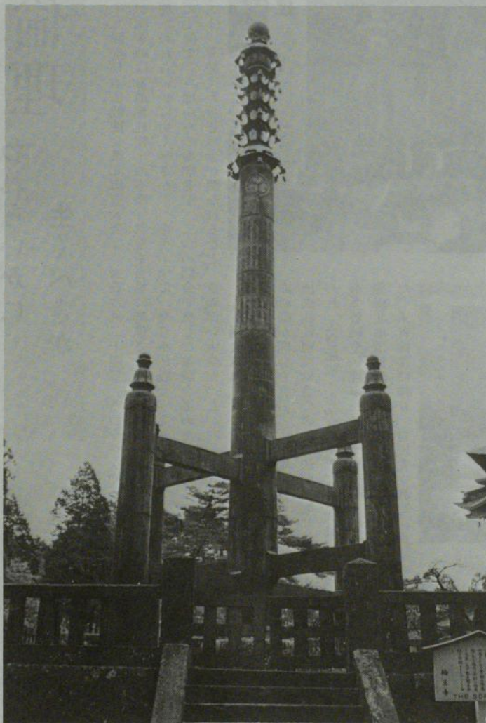
輪王寺・相輪櫓 (栃木県日光市)
