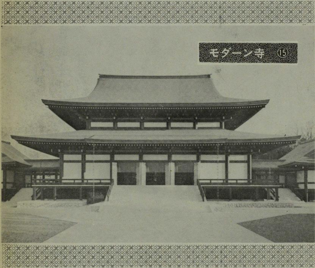
成田山新勝寺本堂(第十七回全日本仏教徒会議々場)
