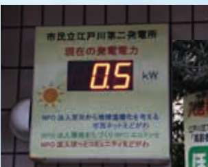
第2発電所(現在の発電電力)
