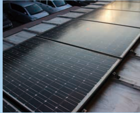
オフグリッドハウス「松江の家」のソーラーパネル
