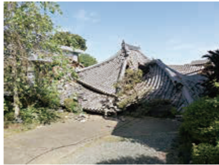
熊本地震により全壊した寺院
