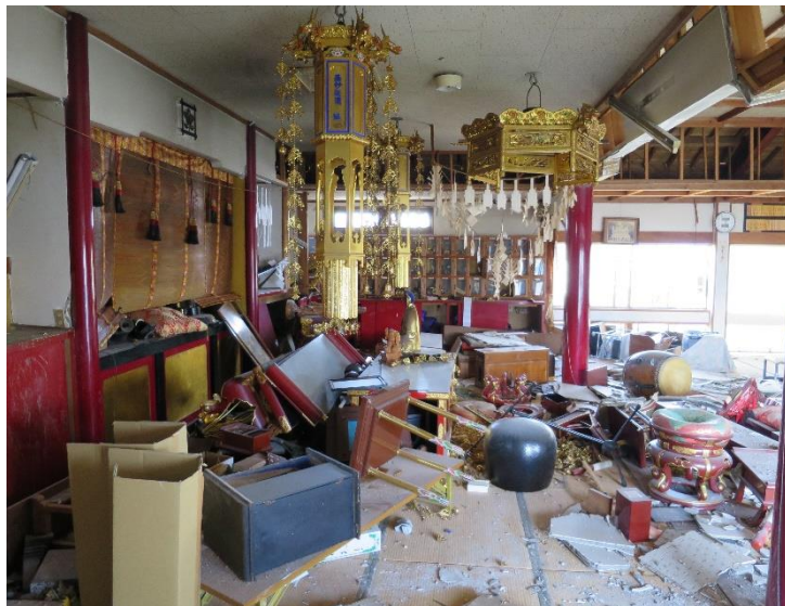
※写真は平成 28 年熊本地震発生時の様子
