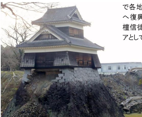
熊本城 戌亥櫓(いぬいやぐら) 崩れた石垣の様子
