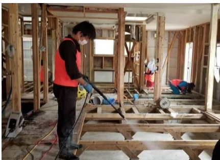
被災した門徒宅の壁剥ぎ・洗浄等
