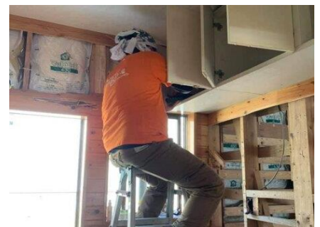
被災住宅の土砂掻き出し、解体等
