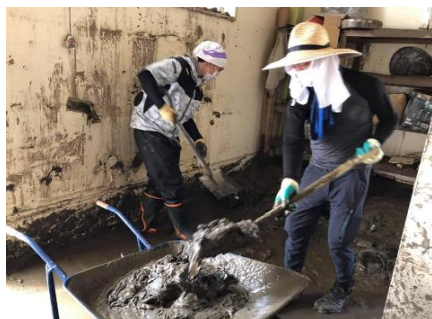
全壊した本堂・境内の復旧作業
