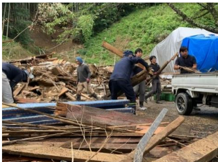
本堂・境内の復旧作業
