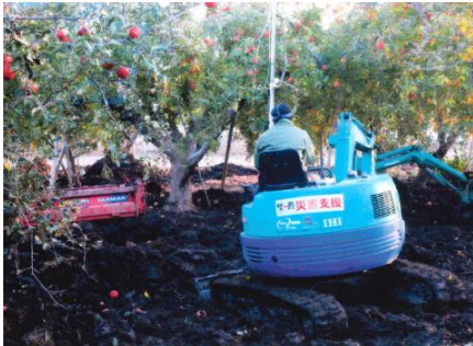
農地等の復旧作業
