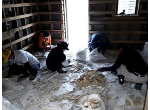
被災住宅の洗浄
