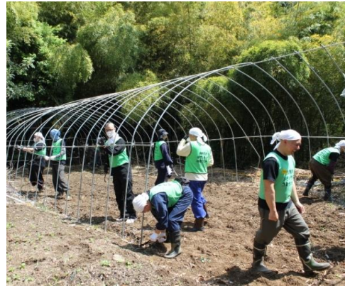
ビニールハウス解体作業
