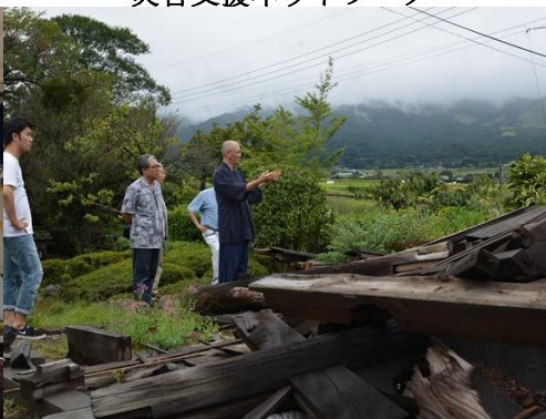
倒壊した寺院本堂
