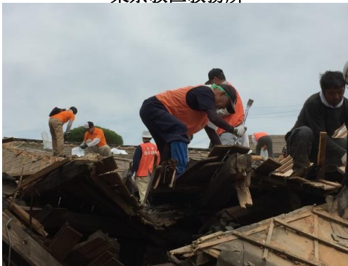
倒壊した寺院本堂の木材撤去
