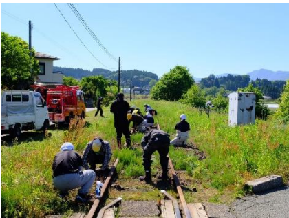
南阿蘇鉄道の復旧作業(草取り)
