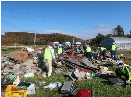
被災した農作業倉庫の後片づけ
